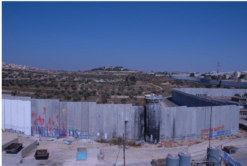
Le Mur vu du camp d'Aïda près de Bethléem.
